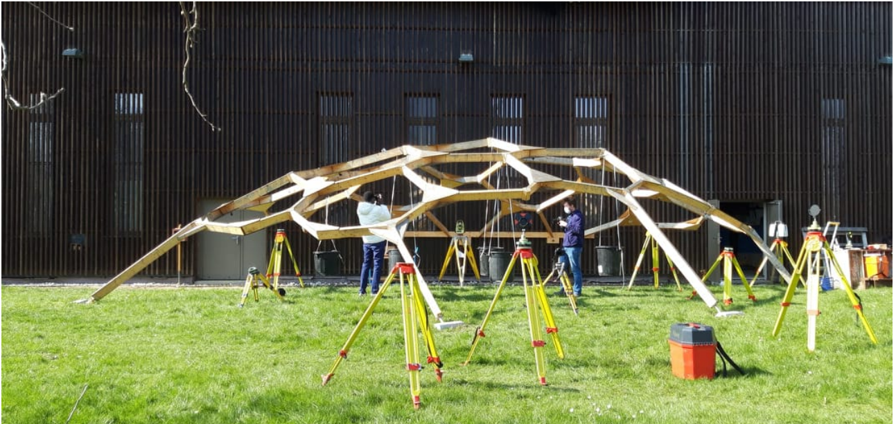
Figure 1: Vue latérale de la structure étudiée.
