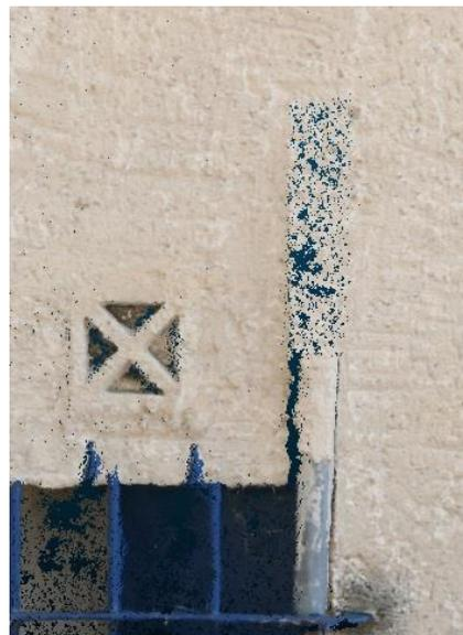
FIGURE III.17 : Résultat Test 2 Détail du modèle 3D obtenu à partir des photos retouchées : zoom sur la gouttière supprimée
